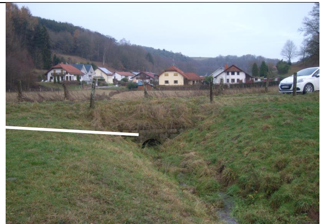
Durchlass an Wegequerung des Labachs: → Weg für Kleinrückhaltung nutzen
