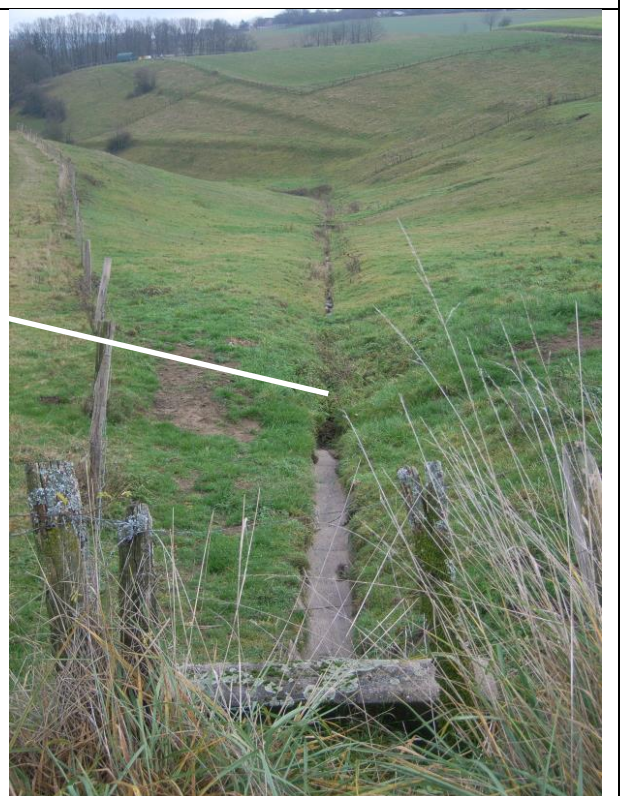
Graben mit Betonhalbschalen in Gefällrichtung zum Steinfelsental:
