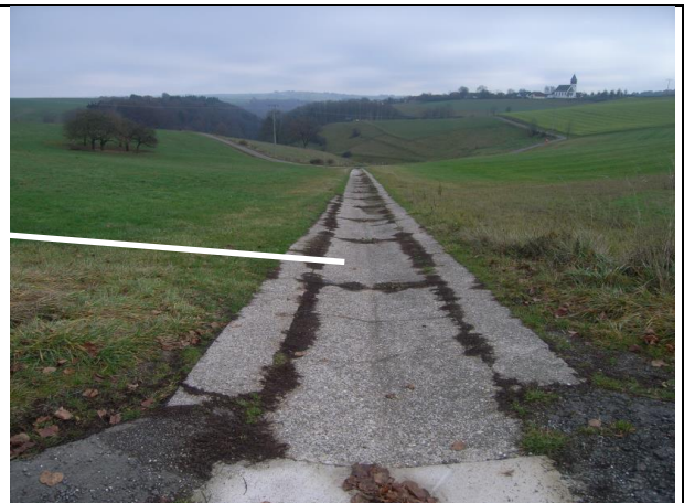
Kombinierte Wege- und Ableitungsrinne in Gefällrichtung zum Steinfelsental
